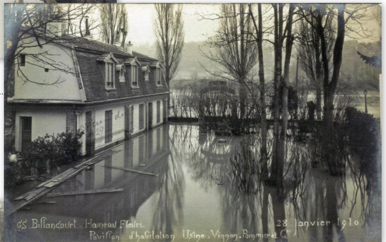
6 Carte issue d'une série de cinq cartes-photos, témoignage sur le Hameau fleuri dû à G. Simard, photographe à Sèvres, identifié par le sigle G. S. Commentaire : « Le pavillon de Pommier et le jardin complètement inondé. »
